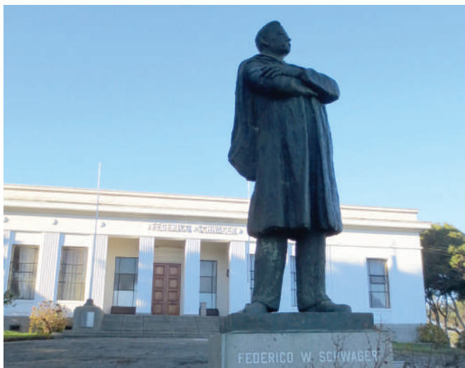
Edificio Administración Compañía. Minera Schwager | Administration building Mining Company Schwager
