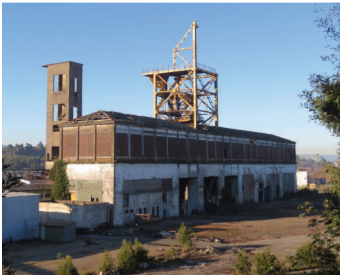
Cabrias del Pique Arenas Blancas | Cabrias del Pique Arenas Blancas
